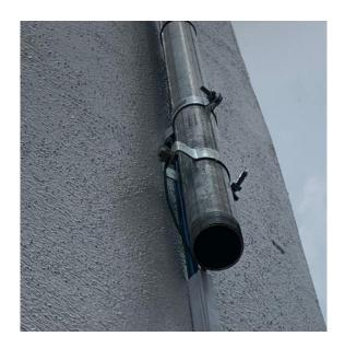
B. Conecte el cable de conexión a tierra de 12 awg (o más grueso) a la correa de conexión a tierra y pase el cable de conexión a tierra desde el poste a la fuente de conexión a tierra.
